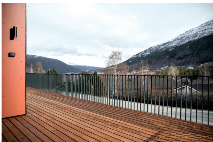
Hver etasje har gode uteplasser, som denne i 2.-etasje med utsikt mot Lom sentrum i sør. Midthaug har levert rekkverk.
